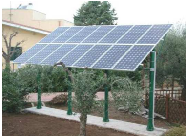
Impianto fotovoltaico "non integrato"
